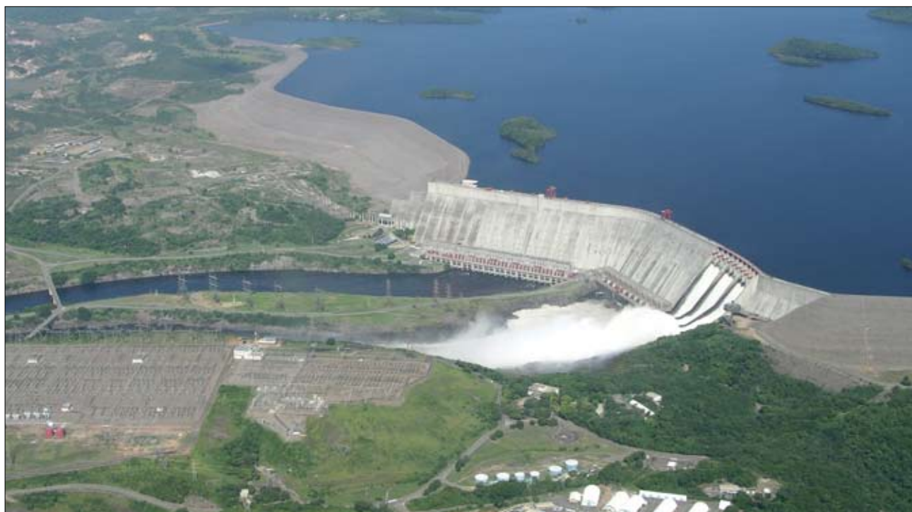
Figura 2.15. Los grandes proyectos hidroeléctricos tales como la Represa Raúl Leóni en Gurí, sobre el río Caroni en Venezuela brindan energía subvencionada para las funciones de aluminio. Al igual que muchas represas, ésta está situada en la boca de un gran río a fin de maximizar la producción de energía eléctrica, que depende del volumen de agua y el desnivel vertical. Sin embargo, la ubicación de la represa en la boca del río también aísla a poblaciones de peces que quedan separadas de toda la cuenca del Orinoco (© Daniela Vizcaino/CI).
