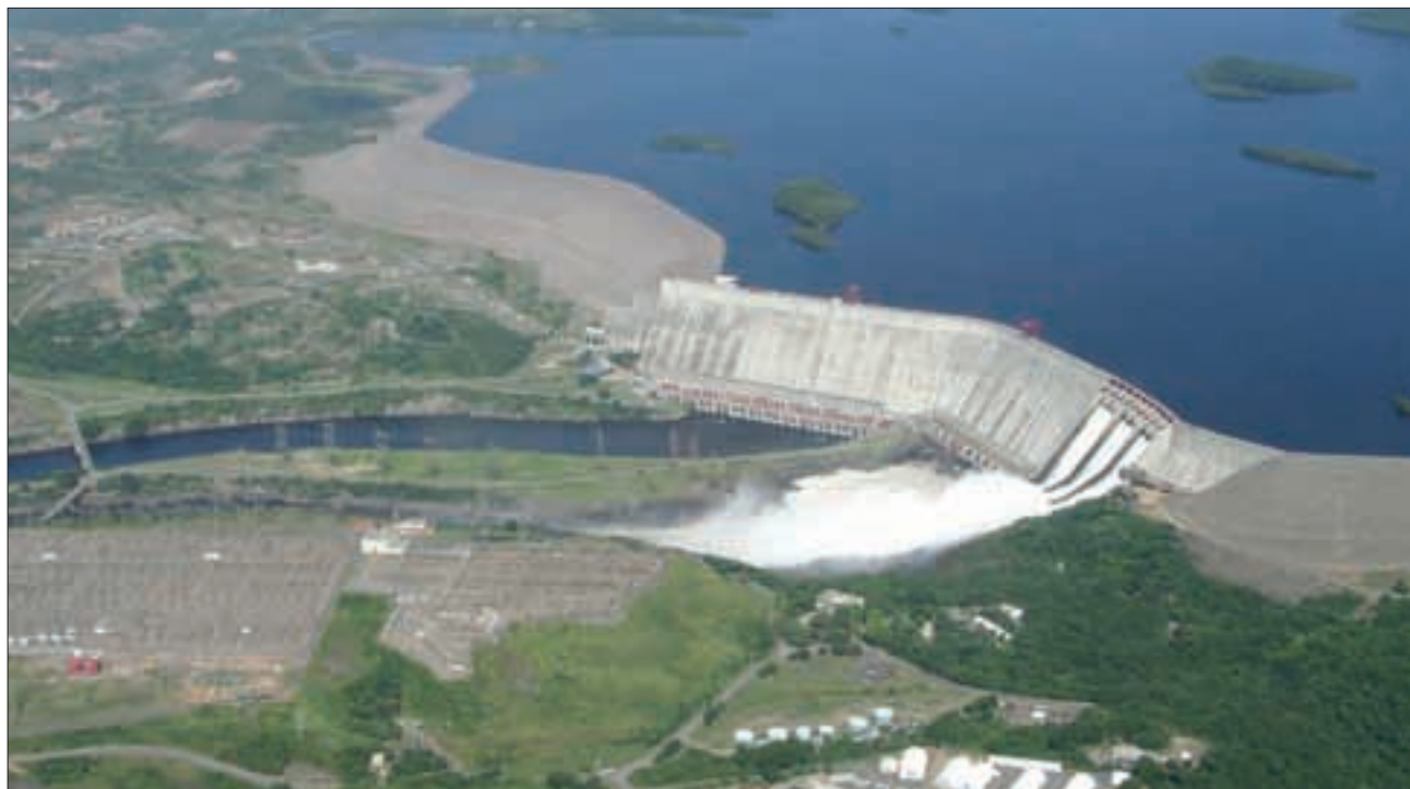
Figura 2.15. Grandes projetos hidrelétricos como o Reservatório Raul Leoni, em Guri, no rio Caroni, na Venezuela fornecem energia subsidiada para a fundição de alumínio. Como muitas represas, ela está localizada perto do delta de um grande rio para maximizar a produção de energia elétrica, que depende de volume de água e quedas verticais. Entretanto, a construção de represas perto dos deltas dos rios também isola populações de peixes de toda a bacia hidrográfica do restante da bacia do Orinoco (© Daniela Vizcaino/CI).
